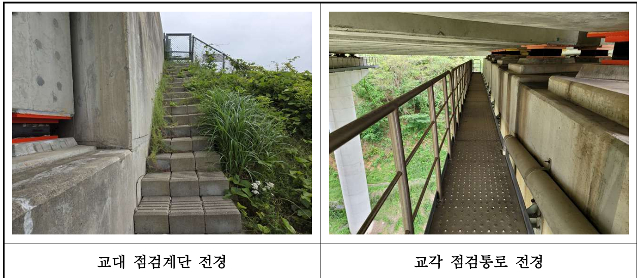
【사진 41.3.26】 교량 점검시설 전경
