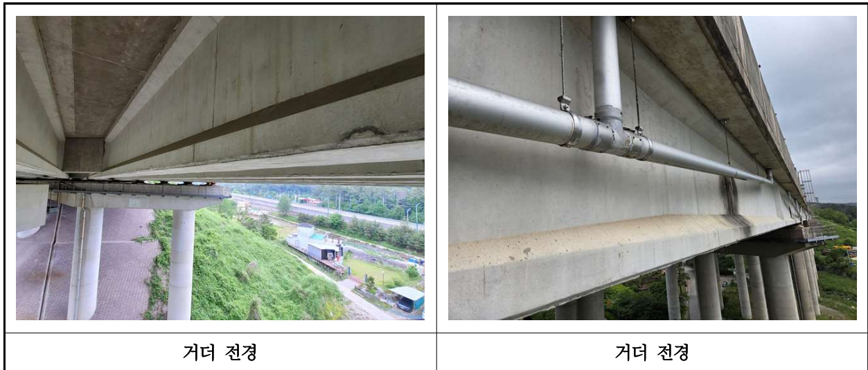
【사진 41.3.4】 거더 전경
