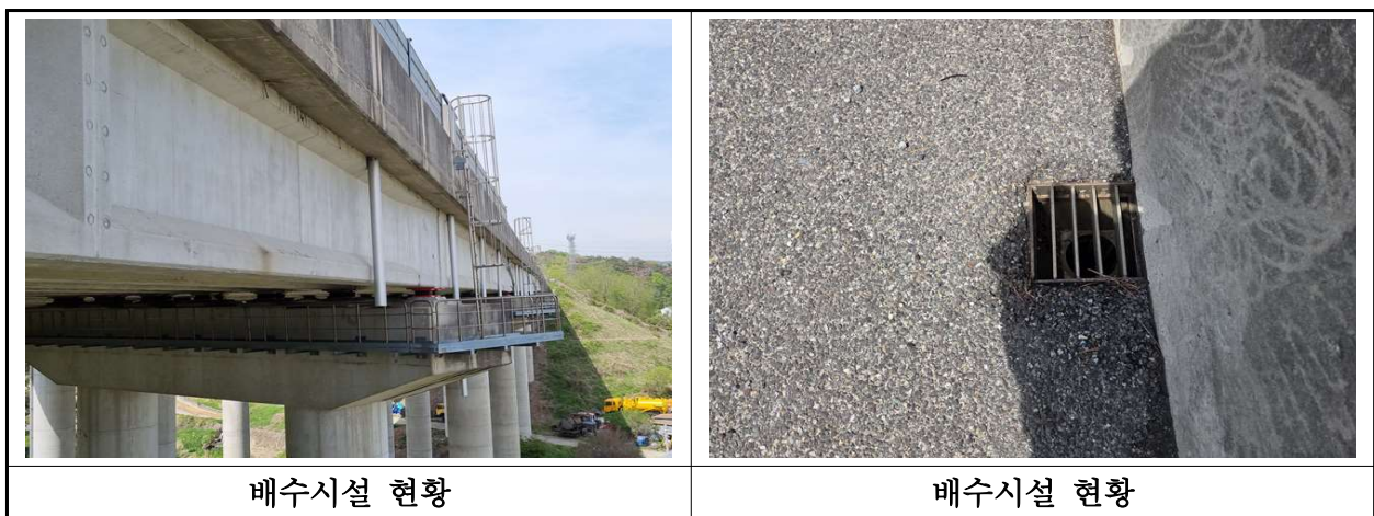
【사진 41.3.22】 배수시설 전경
