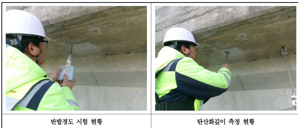
【사진 41.4.1】 콘크리트 내구성조사 현황
