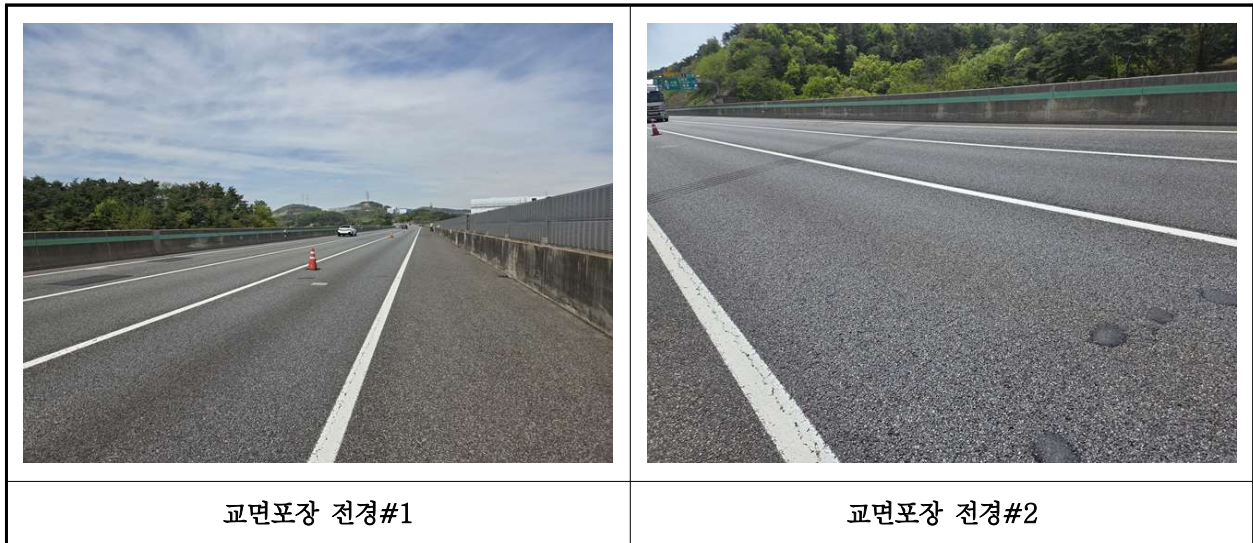
【사진 41.3.20】 교면포장 전경
