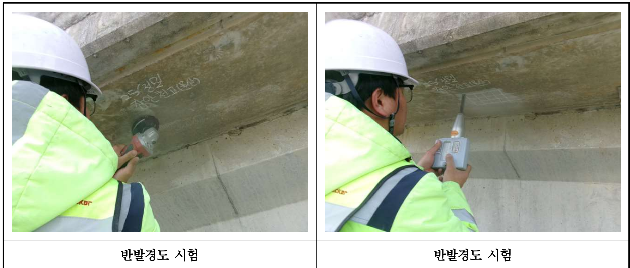
【사진 41.4.2】반발경도시험 현장사진
