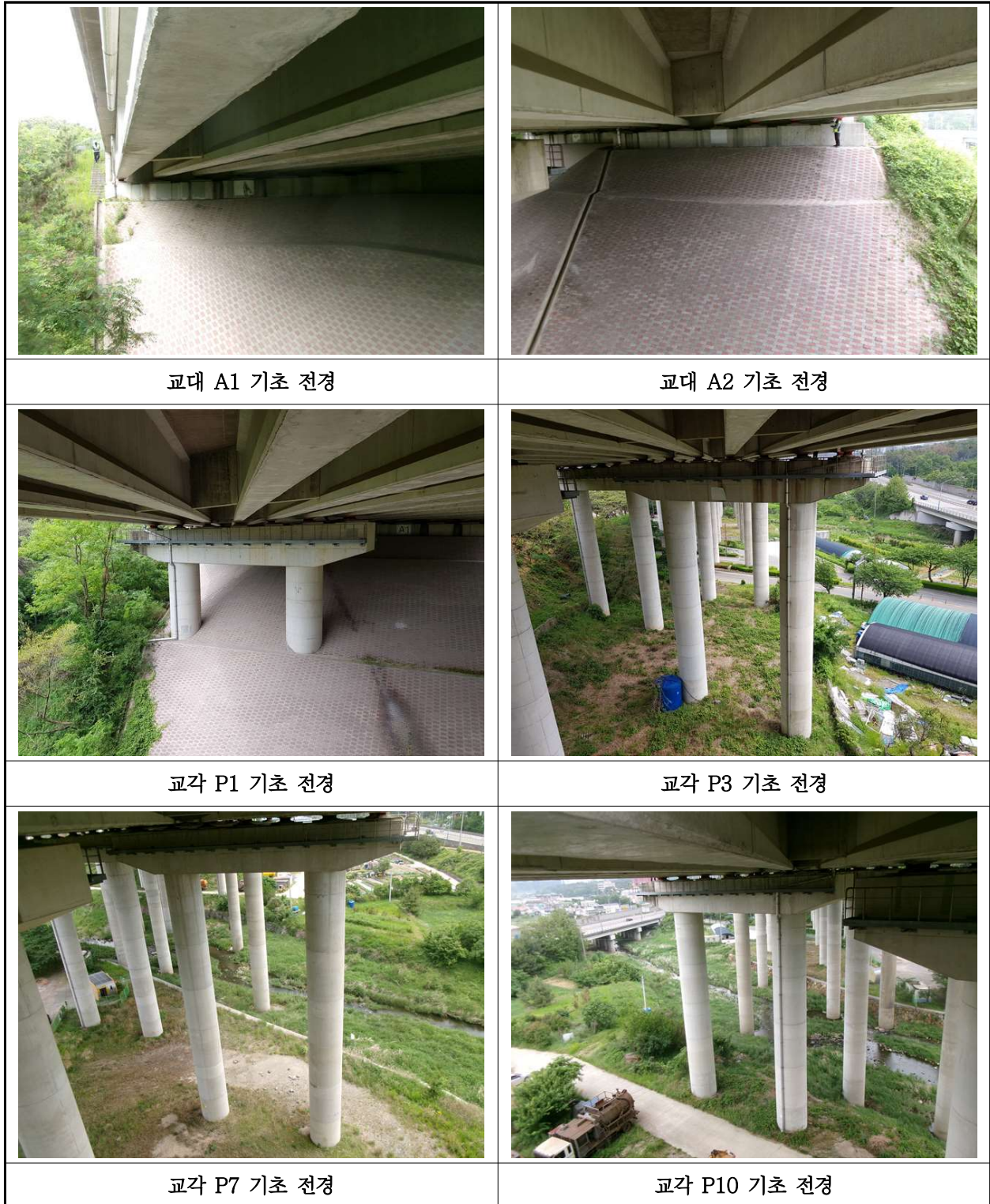
【사진 41.3.12】 기초 전경
