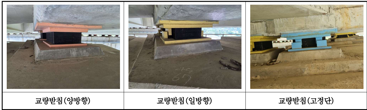
【사진 41.3.13】 교량받침 전경
