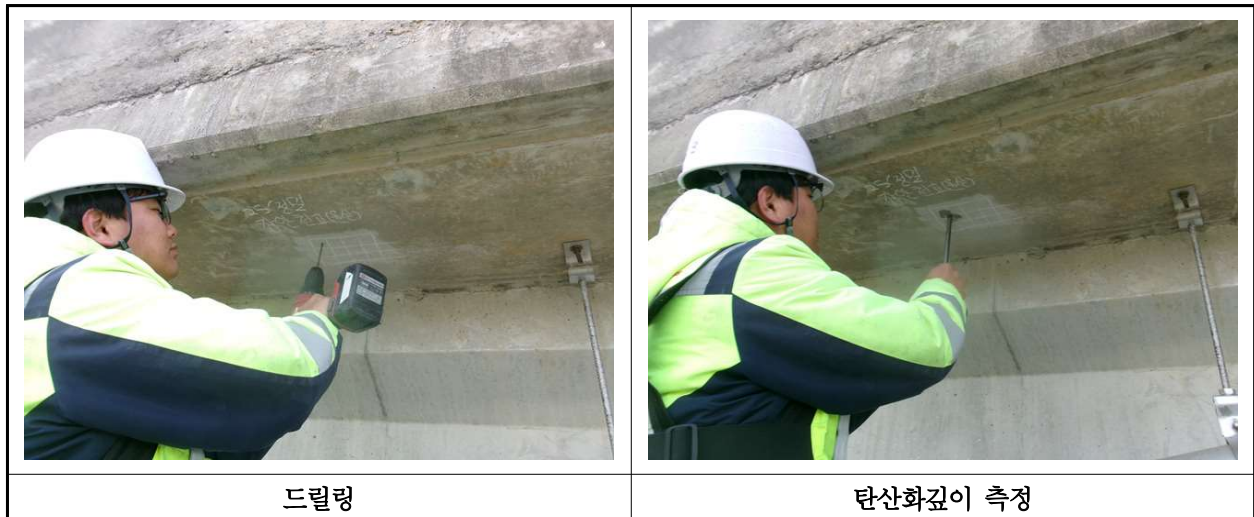
【사진 41.4.3】 탄산화 깊이 측정 현장사진
