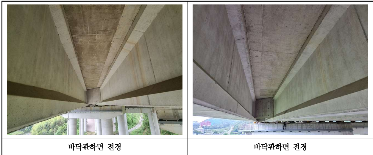
【사진 41.3.2】 바닥판하면 전경
