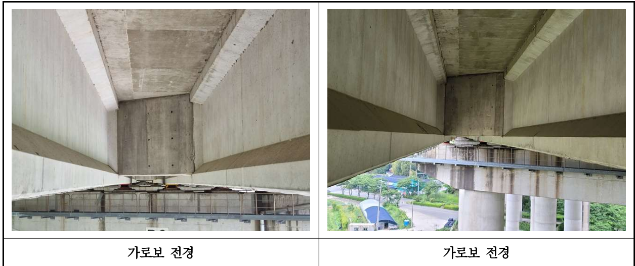
【사진 41.3.6】 가로보 전경
